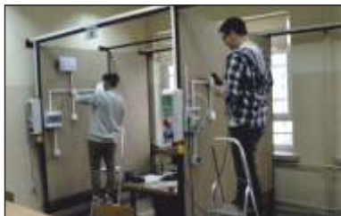
pracownia instalacji elektrycznych
